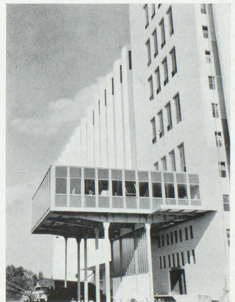
LA CONSTRUCTION ORIGINALE DES BUREAUX DE L'EXPLOITATION COMPLÈTE HARMONIEUSEMENT L'ESTHÉTIQUE DES BATIMENTS
