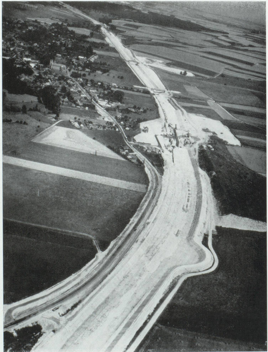
Canal du Nord en chantier.
