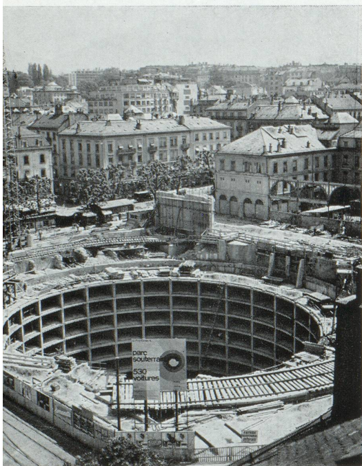
5. Le caisson foncé. (Photo Allpress - Cliché S.R.B.f.l.).
