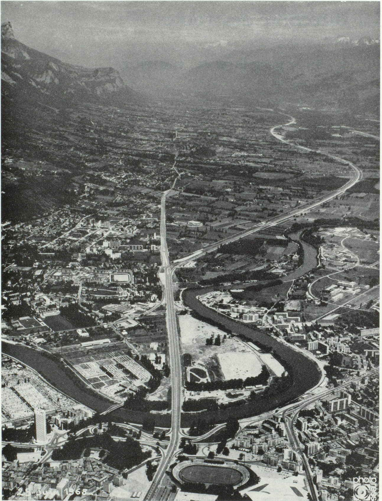
Grenoble. Autoroute A 41, origine sur la voie express Grenoble-Meylan (Photo du Ministère de l'Équipement et du Logement)
