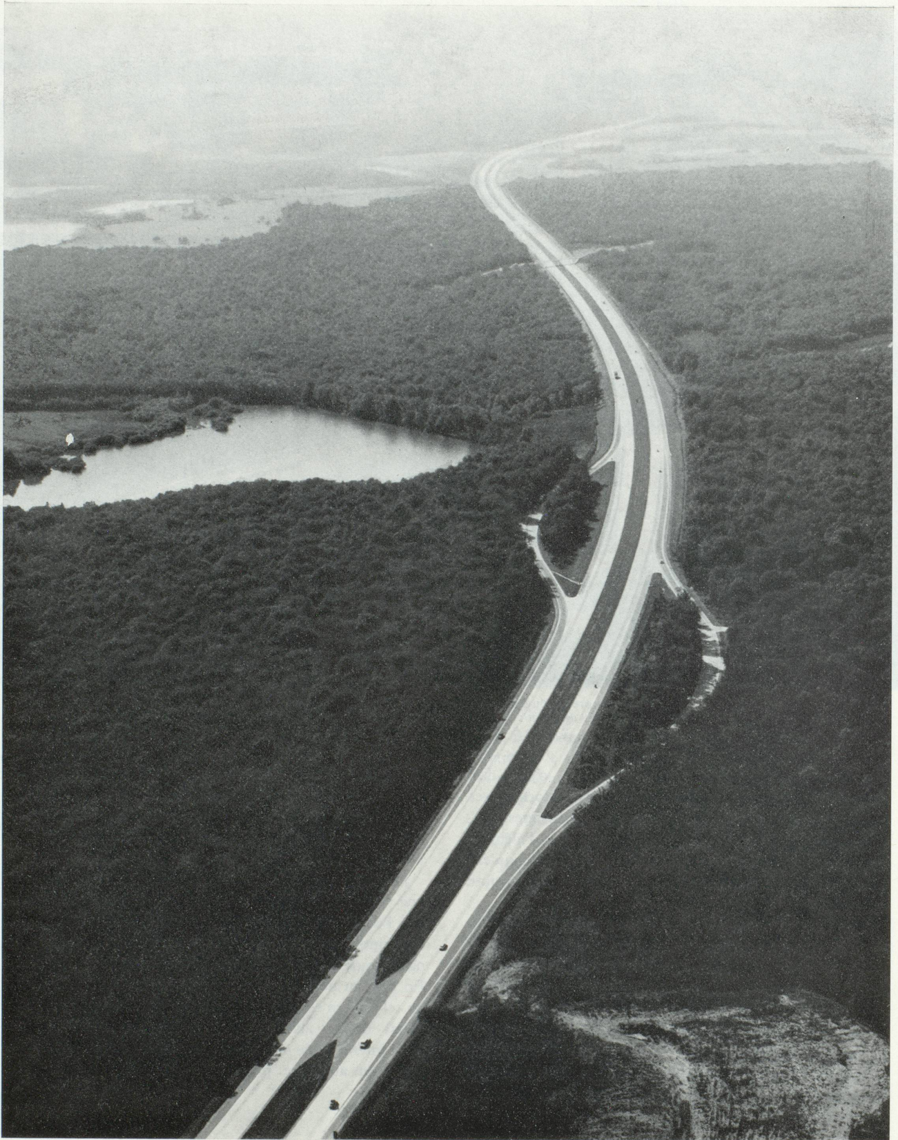
Bois de la Roche. Autoroute du Sud entre Nemours et Auxerre (Photo du Service des relations extérieures de l'Équipement de la Région Parisienne)
