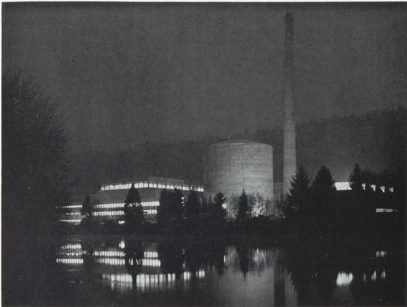
Centrale nucléaire de Mühleberg, photographe F. Meyerhenn.
