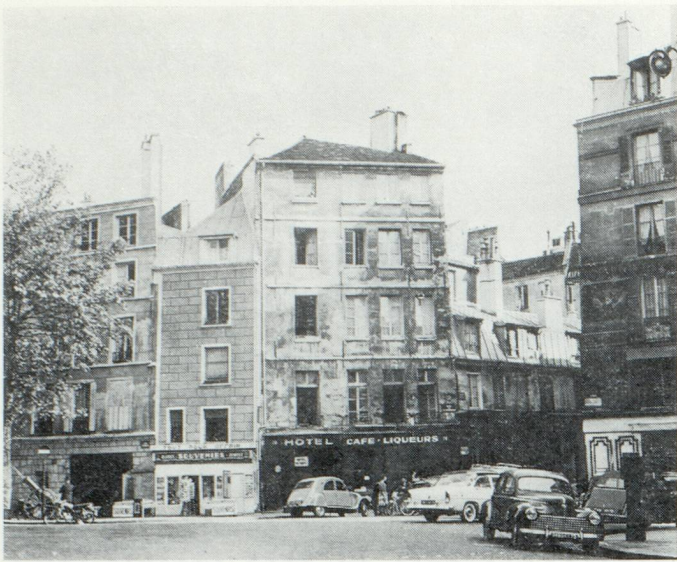
73, quai de la Tournelle avant restauration...
