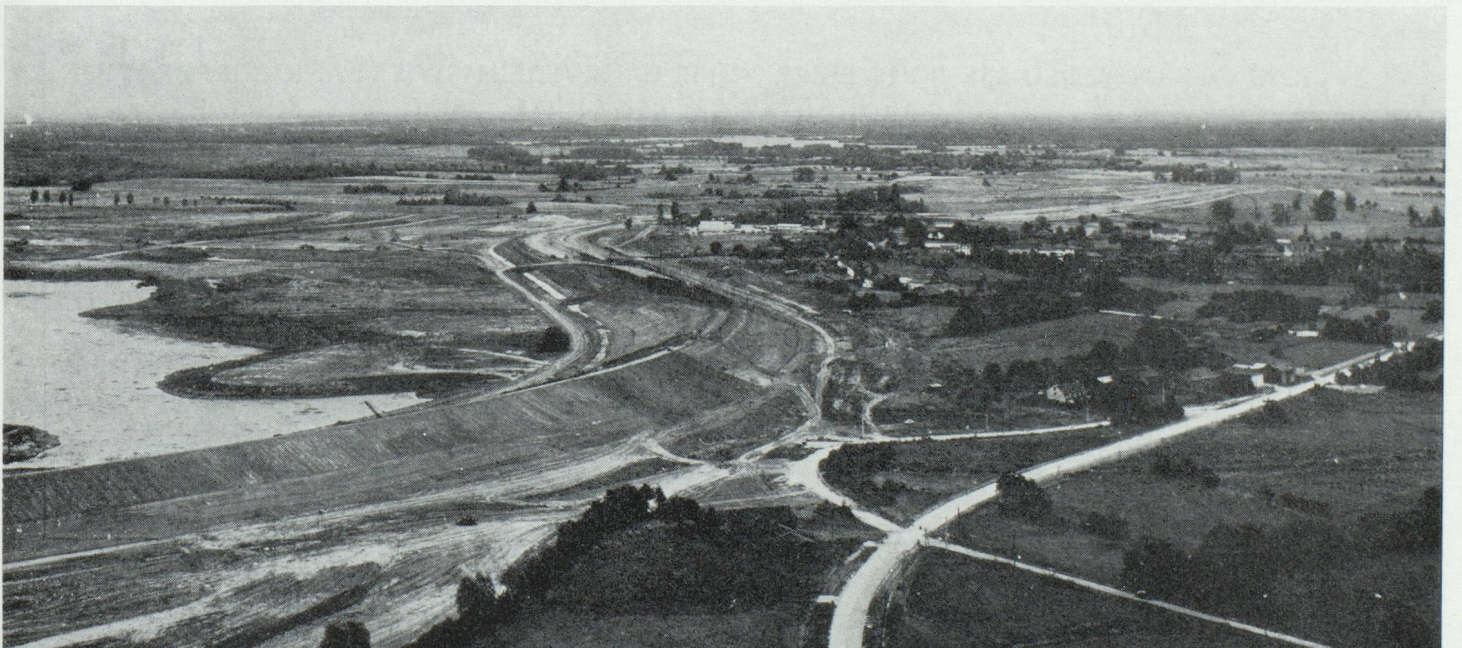
Réservoir « Marne », digue de Giffaumont
