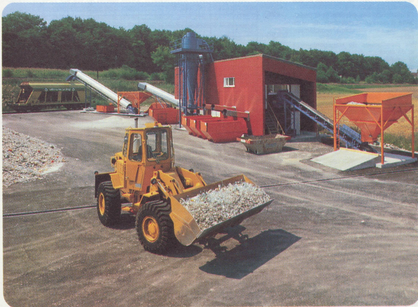
Centre de stockage et de conditionnement de Rümlang (Zürich).
