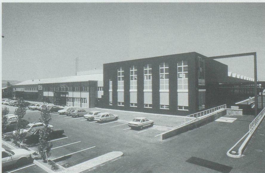
Photo : Les bâtiments de SFS Stadler SA à Valence.
