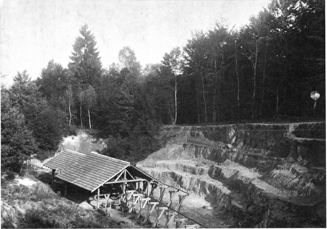
Die Lehmgrube auf dem Berg, die zur Ziegelei Baumer gehörte. Links der Anfang der Seilbahn, die den Lehm in die Stampf brachte, von wo er mit Rollwagen in die Ziegelei befördert wurde.
