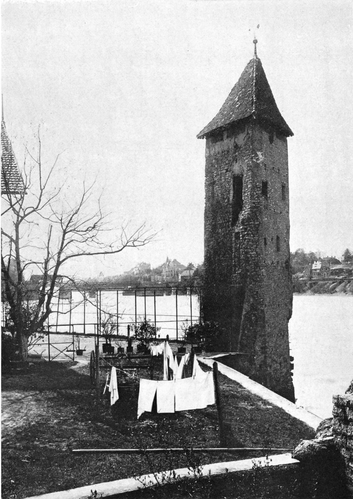
Messerturm. Im Hintergrund die Notbrücke, die nach dem Brand von 1897 das Burgstell mit dem deutschen Ufer verband.
