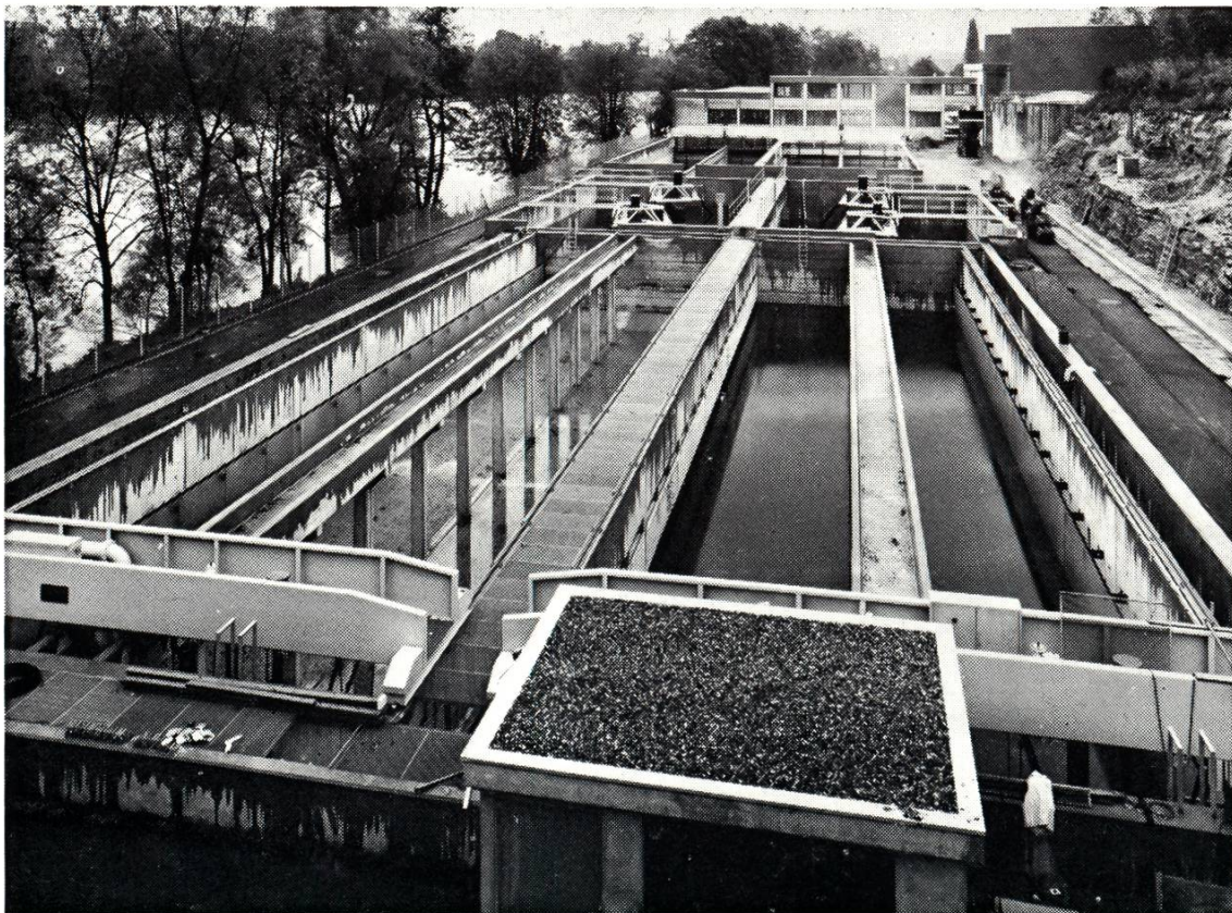
Abb. 6: Kläranlage Augarten, Gesamtansicht Herbst 1976, vor der Betriebsaufnahme
