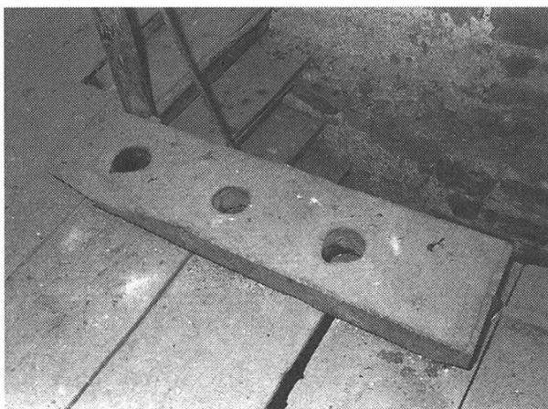
Führung der Riemen durch den untersten Zwischenboden
