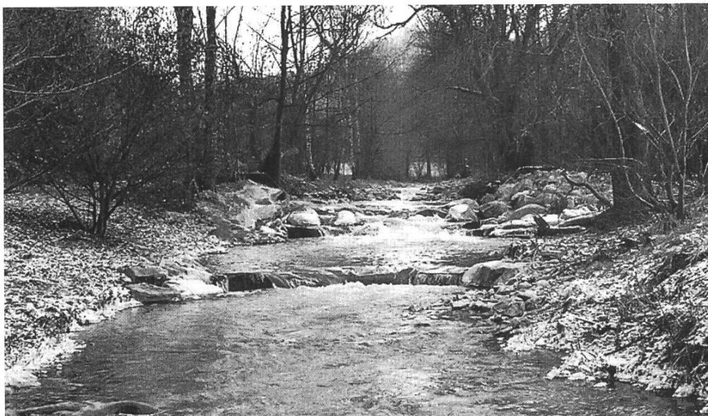
Derselbe Bachabschnitt wie bei Abb. Seite 42 nach der Renaturierung: Blockrampe, reich strukturierte Bachsohle und Ufer, mäandrierender Lauf bei Niedrigwasser; von rechts Einmündung des wieder geöffneten Seitenarms (Dezember 1996).
