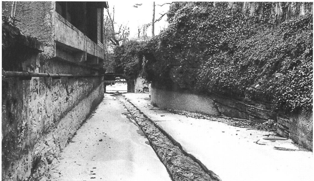
Der Magdenerbach vor der Einmündung in den Rhein vor dem Umbau: ökologisch tote Betonschussrinne (März 1993). Fotos: F. Lüscher
