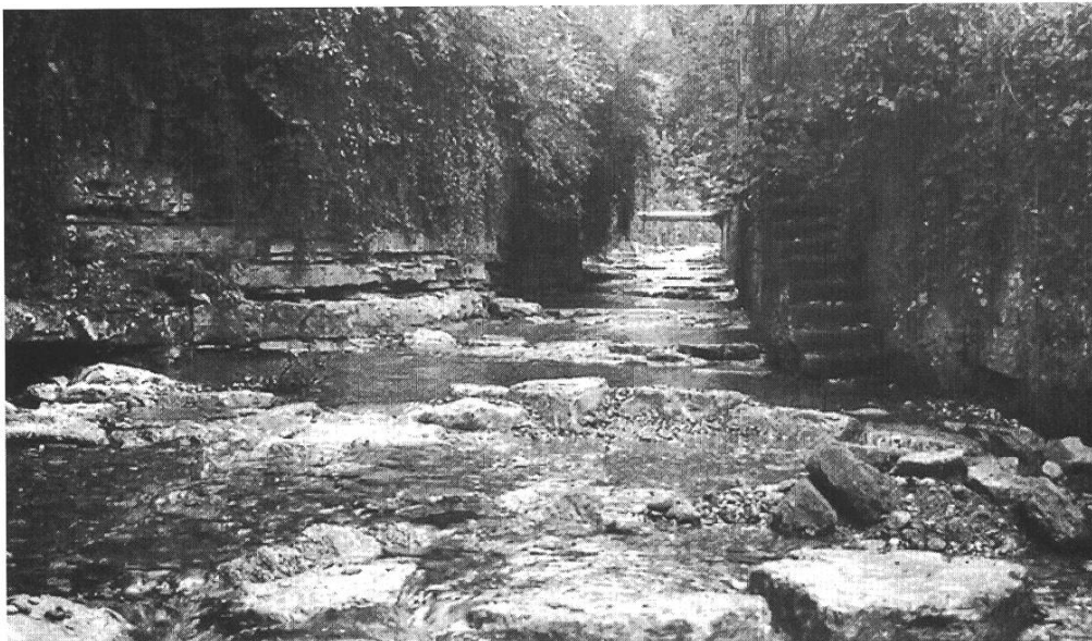
Derselbe Bachabschnitt wie bei Abb. Seite 46 nach der Renaturierung bachaufwärts fotografiert (Mai 1995).
