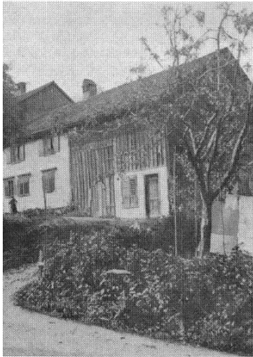
Wohnhaus der Eheleute Kohler in Wilen (Thurgau) 1857–1865. Sterbehaus der Pe-regrina.
