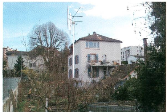
Abbildung oben: Foto der Photovoltaikanlage auf dem Dach des Altersheims Lindenstrasse.
