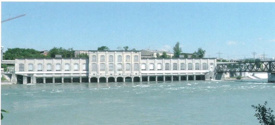
Das alte Wasserkraftwerk Rheinfelden kurz vor seinem Abbruch.
