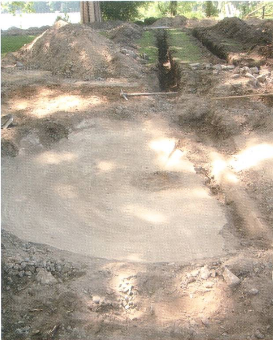
Fundamente der historischen Brunnenschale.
