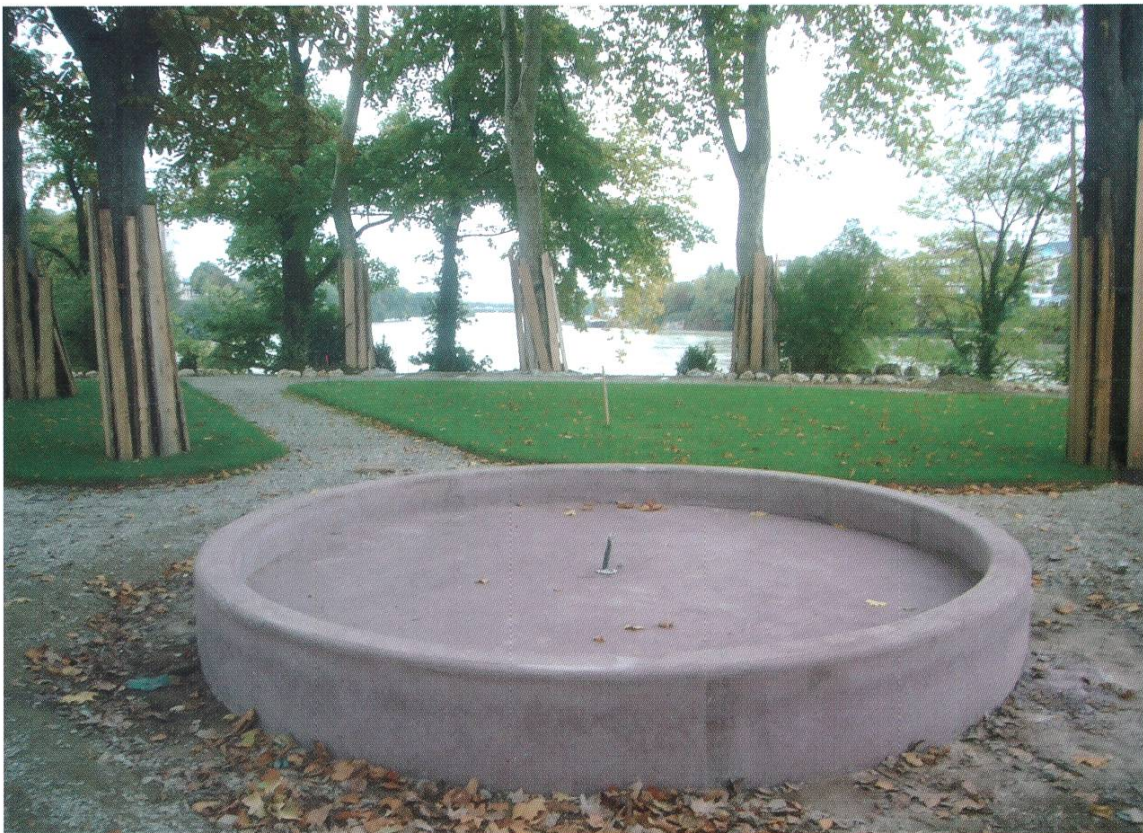
Neue in Beton gegossene Brunnenschale.
