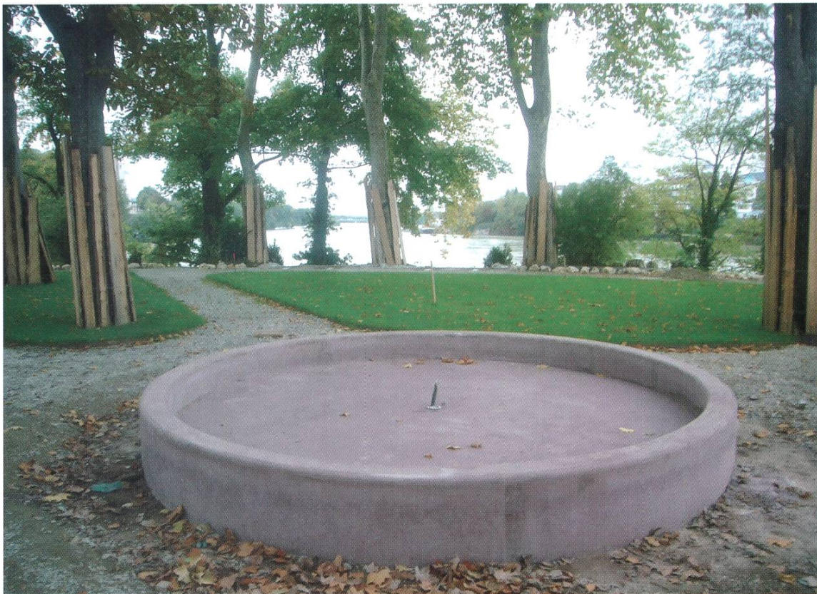
Neue in Beton gegossene Brunnenschale.
