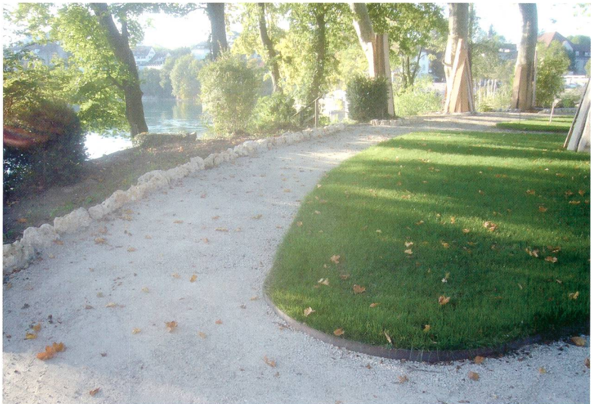
Rekonstruktion der Wegeinfassung.
