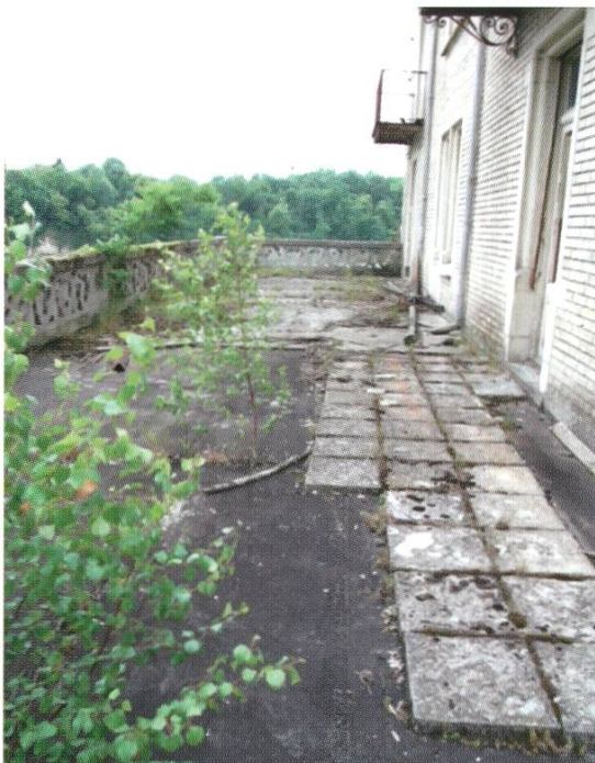
Die Terrasse vor der Renovation.
