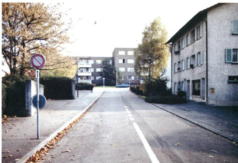
Die Liegenschaft an der L'Orsa-Strasse 15 aus dem Jahre 1977. (Quelle: Markus Bieber)
