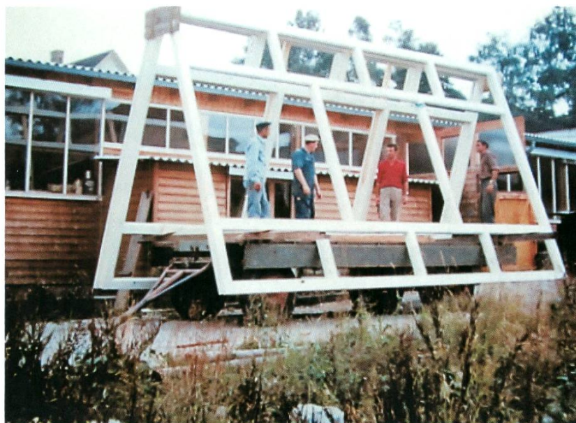
Die Marke, Hurni – Fenster. (Quelle: Hanni Fischer-Hurni)
