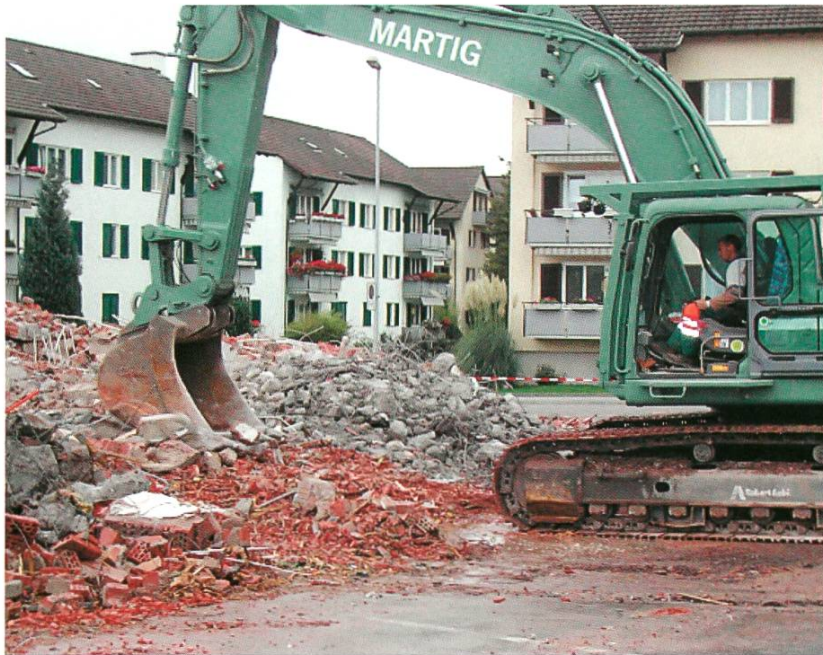
Abriss des alten Werkhofs an der Lindenstrasse. Im Hintergrund bereits der Neubau der Wohnbau-genossenschaft Zähringer. (Foto: Marcel Hauri)
