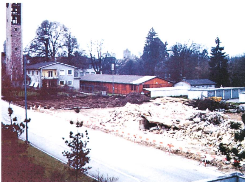
Migros Neubau kurz vor Baubeginn. (Quelle: Markus Bieber)
