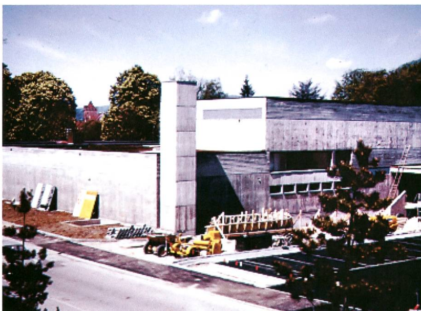
Der Migros Neubau ist fast fertig. Aufnahme aus dem Jahre 1969. (Quelle: Markus Bieber)
