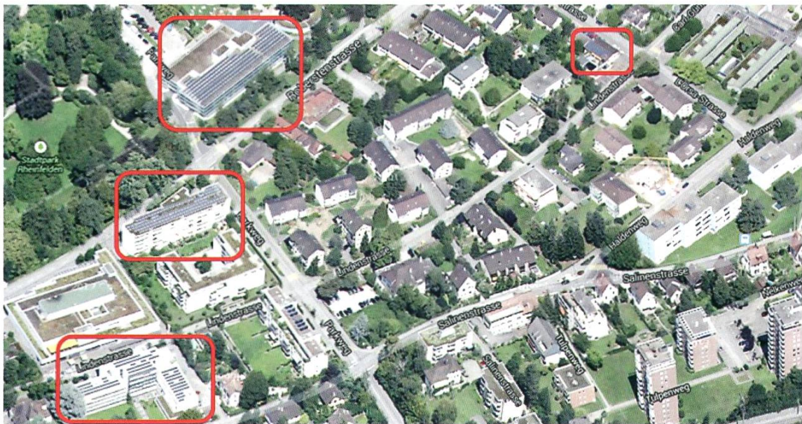
Luftansicht der PV-Anlagen Alters- und Pflegeheim, Zähringer, Parkhaus und L'Orsa-Strasse.
