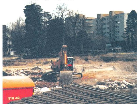
Wohnblock/Bagger fährt auf
