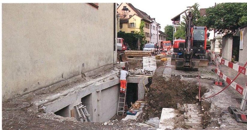
Der Bunker unter der Kapuzinerkirche
