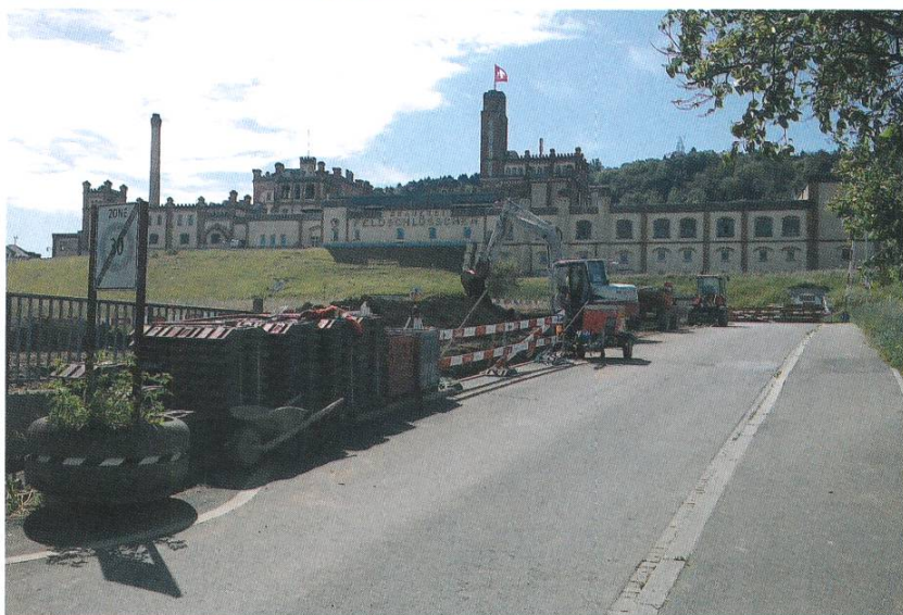
Tiefbauarbeiten an der Kloosfeldstrasse
