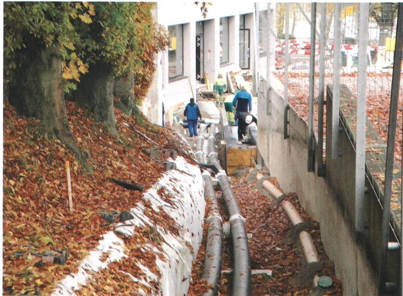
Tiefbauarbeiten beim Ölwegli
