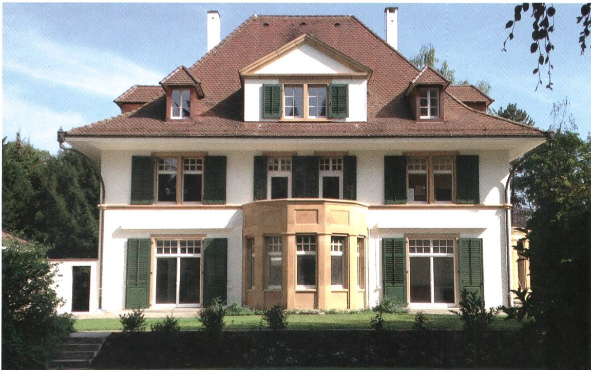
Ansicht von Süden der Liegenschaft an der Kaiserstrasse 21.
