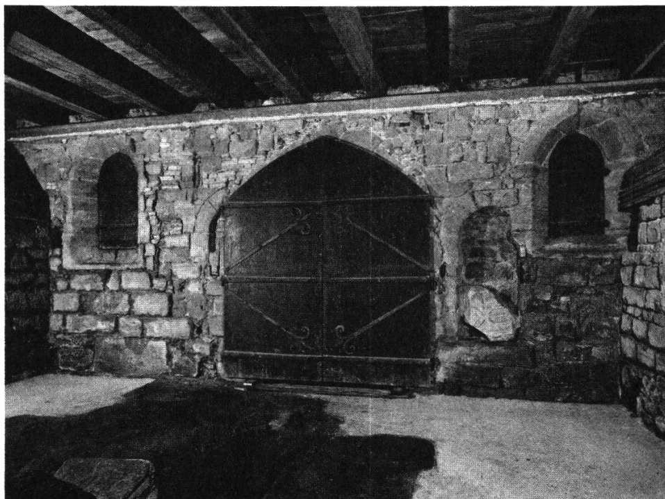
Fig. 6. Mur oriental de la salle capitulaire.
