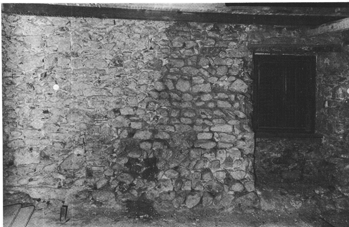
Fig. 14. Segment du mur d'enceinte roman avec, à gauche, la porte des vignes supprimée en 1819.
