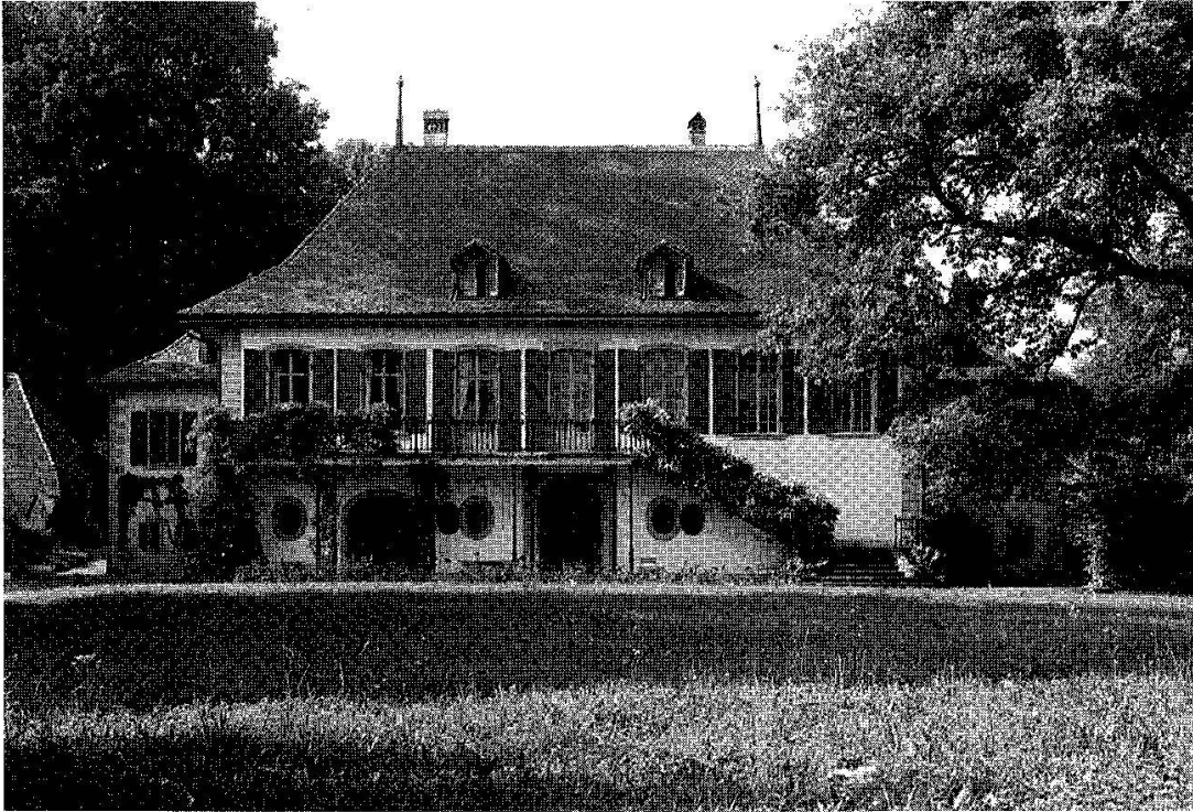
Fig. 10. La façade côté lac, état actuel.
