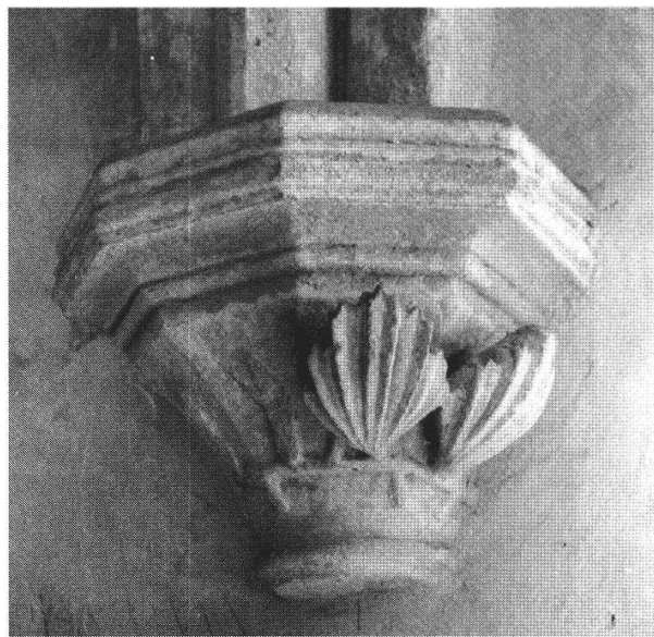
Fig. 23. Petit cloître de La Lance, cul-de-lampe recevant les nervures de la travée nord, contre le mur de l'église. Était-il prévu pour reposer sur une colonnette ? État en 1967.
