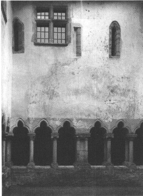
Fig. 30. Petit cloître de La Lance. Mur nord. Les baies en lancette trilobée, sans doute originales, éclairaient peut-être une pièce du logement réservé au prieur. État en 1967.
