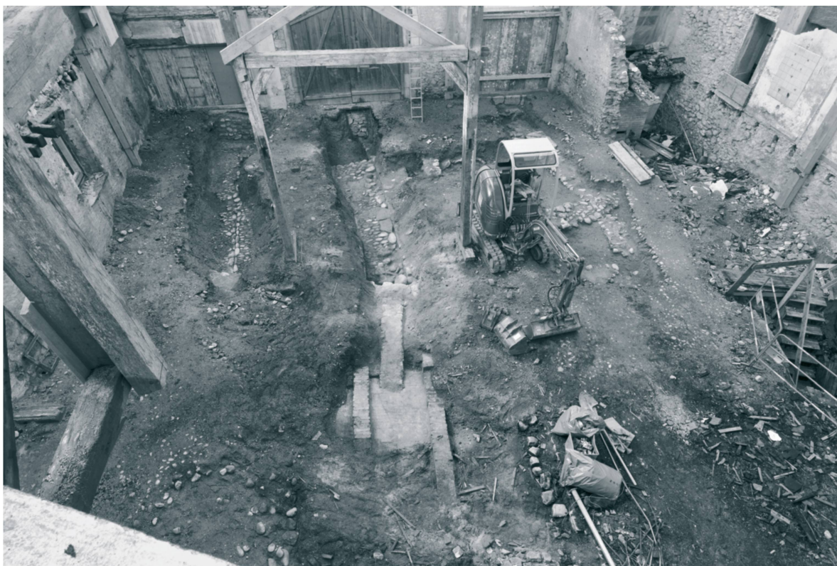
Fig. 1. Aubonne – Rural de l’Hôtel de la Couronne. Vue générale. Le pavage en galets est visible dans les deux tranchées (photo Fibbi-Aeppli, Grandson).
