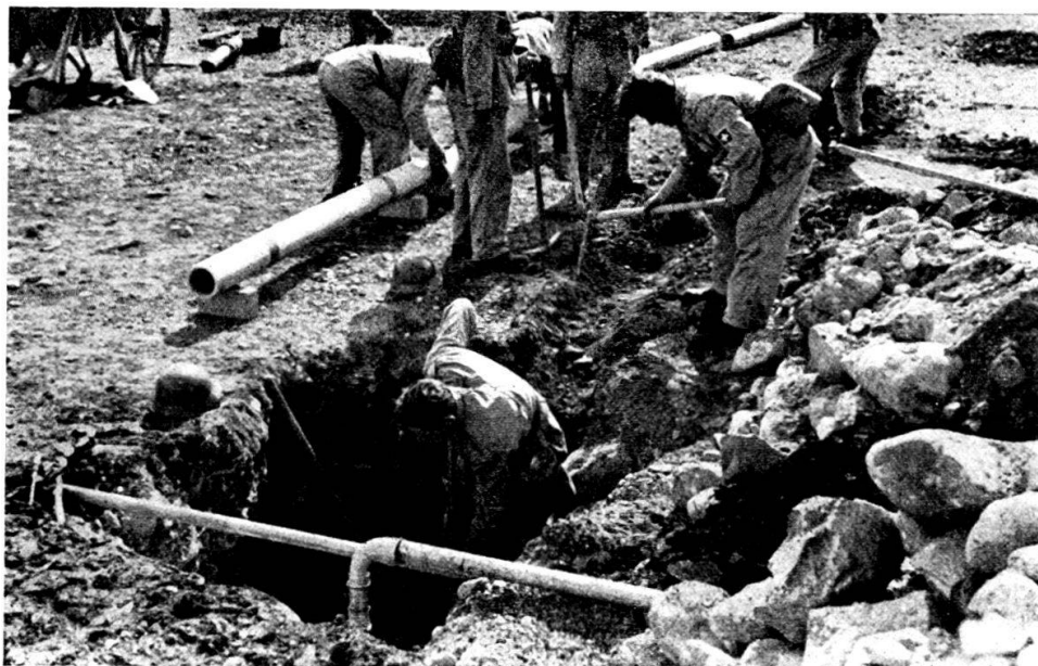
Servizio tecnico: riparazione di condotte distrutte.
