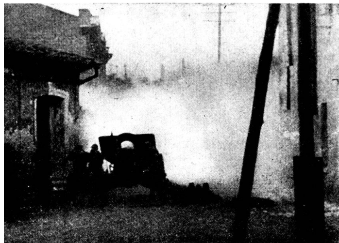
11. Cannone pesante in tiro diretto contro le coperture del difensore.
