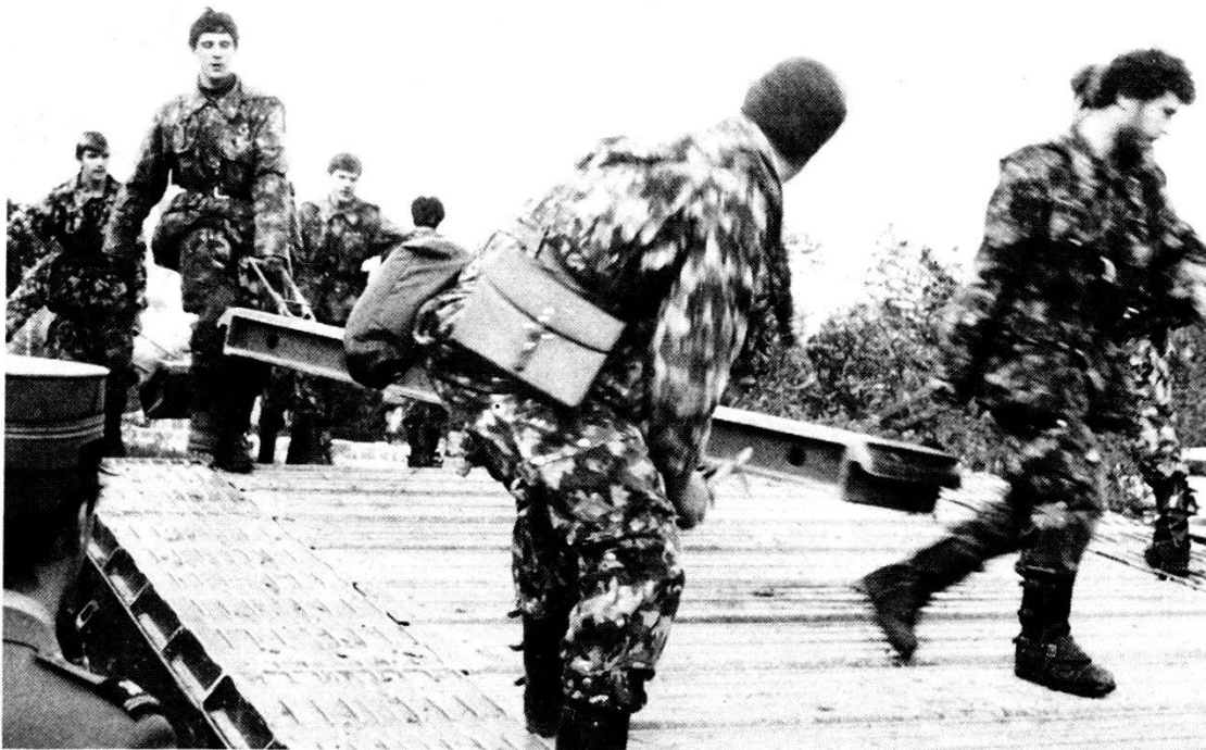
Fase di costruzione del ponte fisso 69, da parte dei militari ticinesi.
