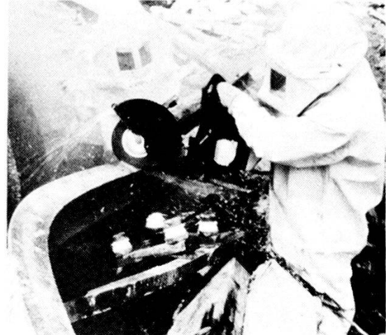
Motosega a disco. Con la motosega a disco si possono tagliare condotte metalliche e ferro d'armatura.
