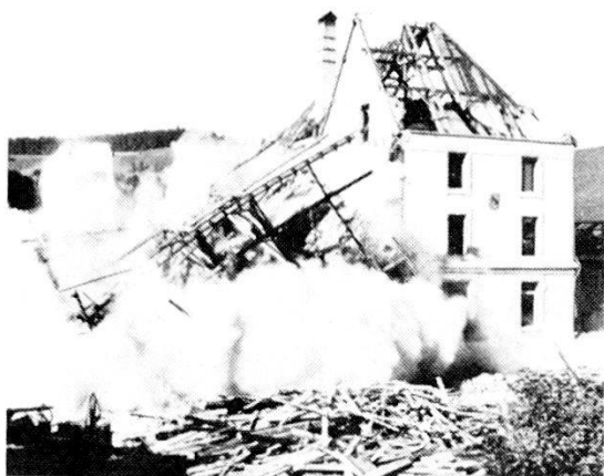
Brillamenti. Resti pericolanti di costruzioni vengono fatti saltare nell'ambito dei lavori di ripristino.
