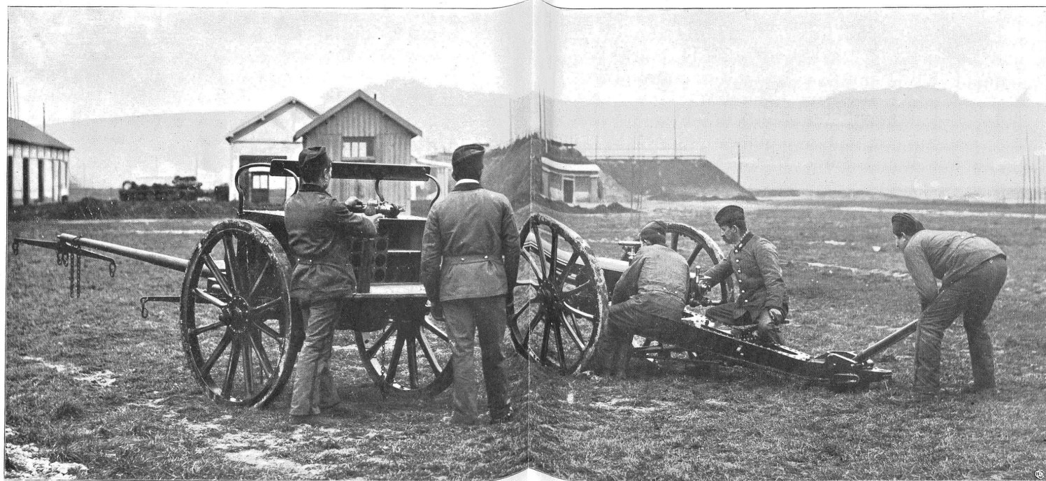
Canon de 75 mm de campagne à tir rapide, système Schneider-Canet. — Pièce en batterie.
