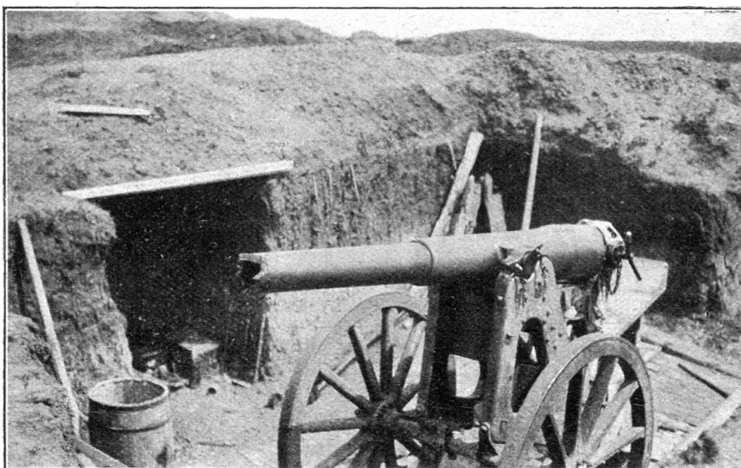
Fig. 11. — Canon turc de 10 cm. brisé à la bouche.
