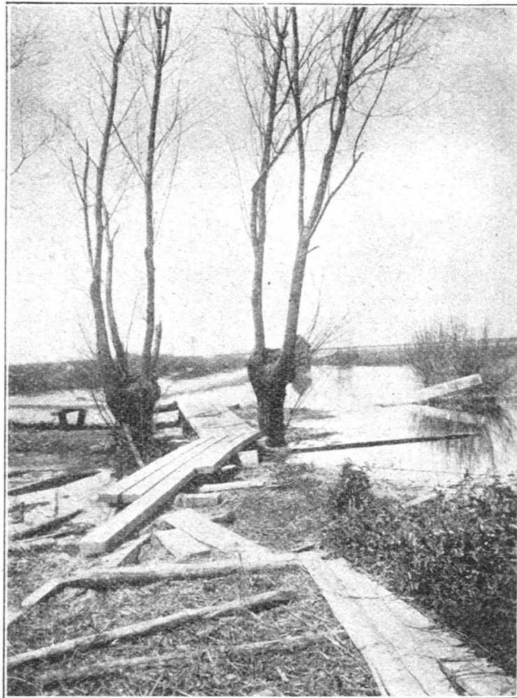
Chemin de colonnes à travers l'inondation.
