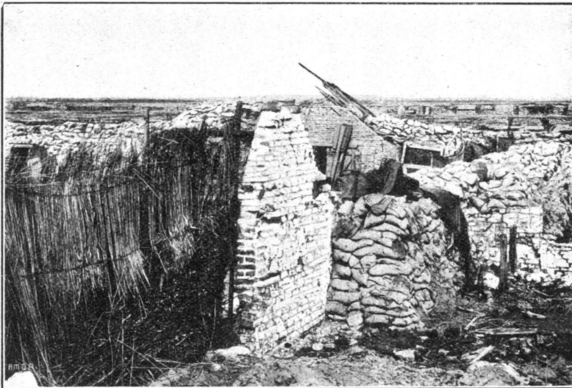
Au front belge. — Un aspect des travaux de défense.
