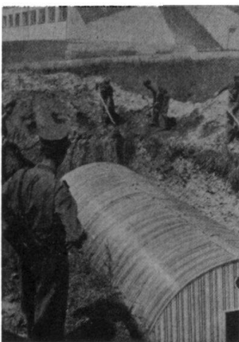
FIG. 5. Empilement du matériel pour un abri- tunnel de 4 m.
