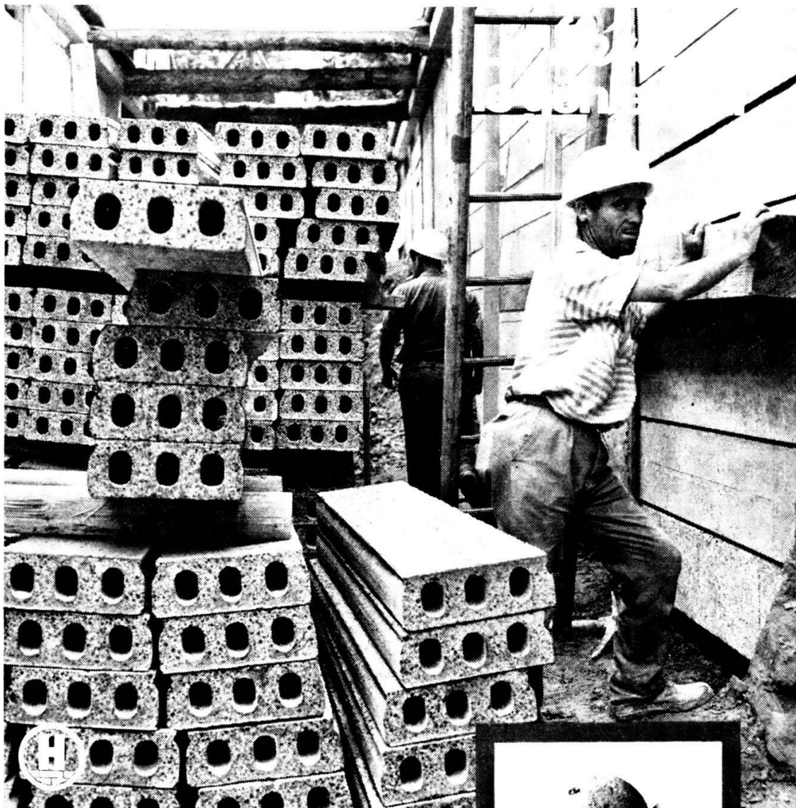
Utilisation de panneaux de toiture Leca comme coffrage perdu pour la canalisation du chauffage à distance du Käferberg à Zurich Maître de l'ouvrage: Services industriels de la ville de Zurich Calcul statique: Bureau des constructions des Services industriels de la ville de Zurich Entrepreneur: Locher + Cie SA, Zurich
