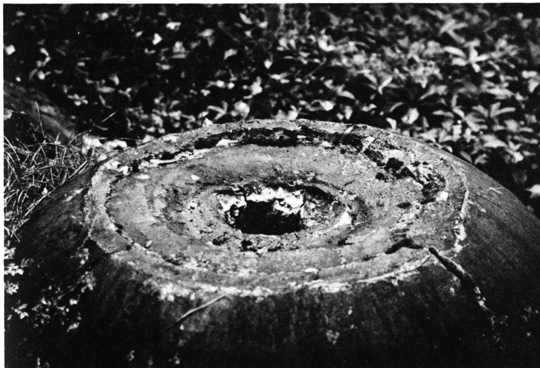
Coupole percée à l'aide d'une charge creuse appliquée.
