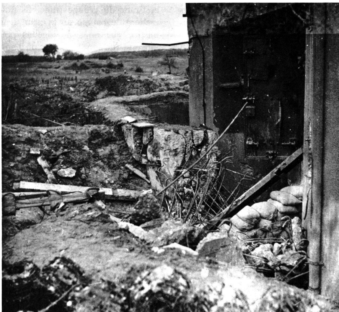
Le fossé arrière de la casemate.
