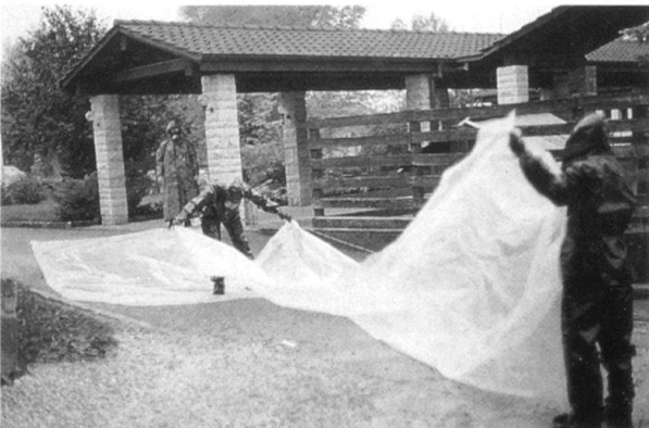
2. Construction d'un chemin d'évacuation
