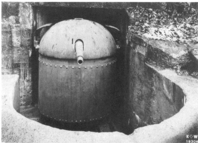
Canon de 5,3 cm 1887 sur affût cuirassé mobile, qui a armé tous les forts du Gothard. La plaque de base est renforcée par des fers profilés reposant sur deux axes munis de galets à boudin permettant le déplacement de la pièce de son abri à la position de tir. Pour ce faire, on utilise une voie ferrée de 60 cm d'écartement
