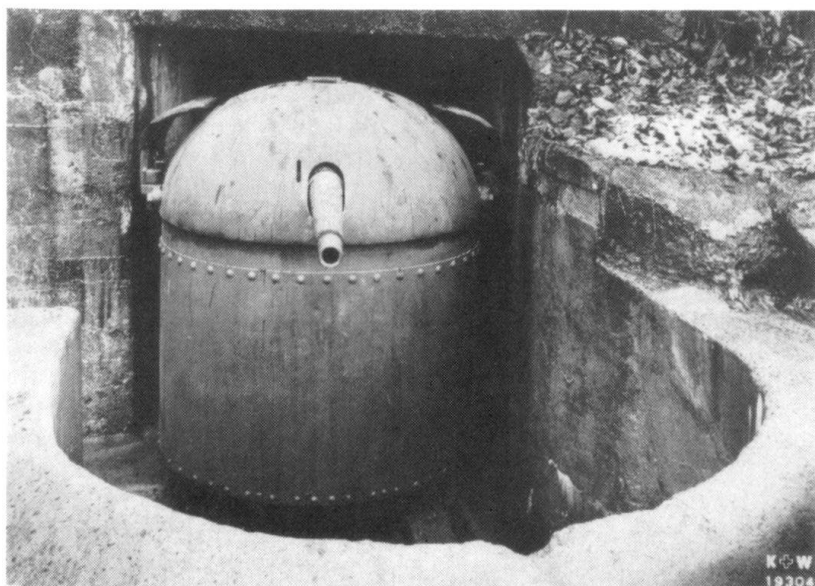
Canon de 5,3 cm 1887 sur affût cuirassé mobile, qui a armé tous les forts du Gothard. La plaque de base est renforcée par des fers profilés reposant sur deux axes munis de galets à boudin permettant le déplacement de la pièce de son abri à la position de tir. Pour ce faire, on utilise une voie ferrée de 60 cm d'écartement
