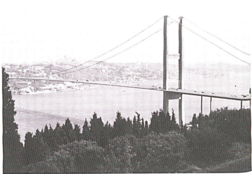
Le Bosphore sépare les parties européenne et asiatique de la ville d'Istanbul. Le «pont de l'Europe», pendant longtemps l'ouvrage d'art le plus long du monde... (Photo H. W.).
