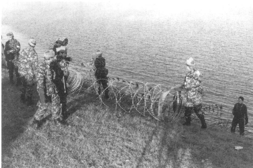
Novembre 1985, Sommet Reagan-Gorbatchev. Mise en place de barbelés à proximité de la résidence de Ronald Reagan.
