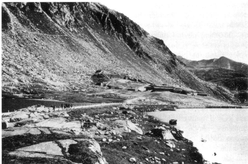
L'ouvrage de l'Hospice et l'ancienne route du col. (Zentralbibliothek Zürich).
