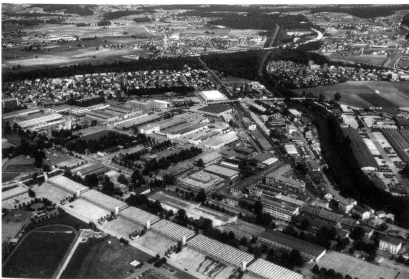
Les exploitations de la SM se situent à Thoune et à Altdorf. Vue des exploitations militaires et de la place d'armes de Thoune. Le site de la SM longe la rive gauche de l'Aar.
