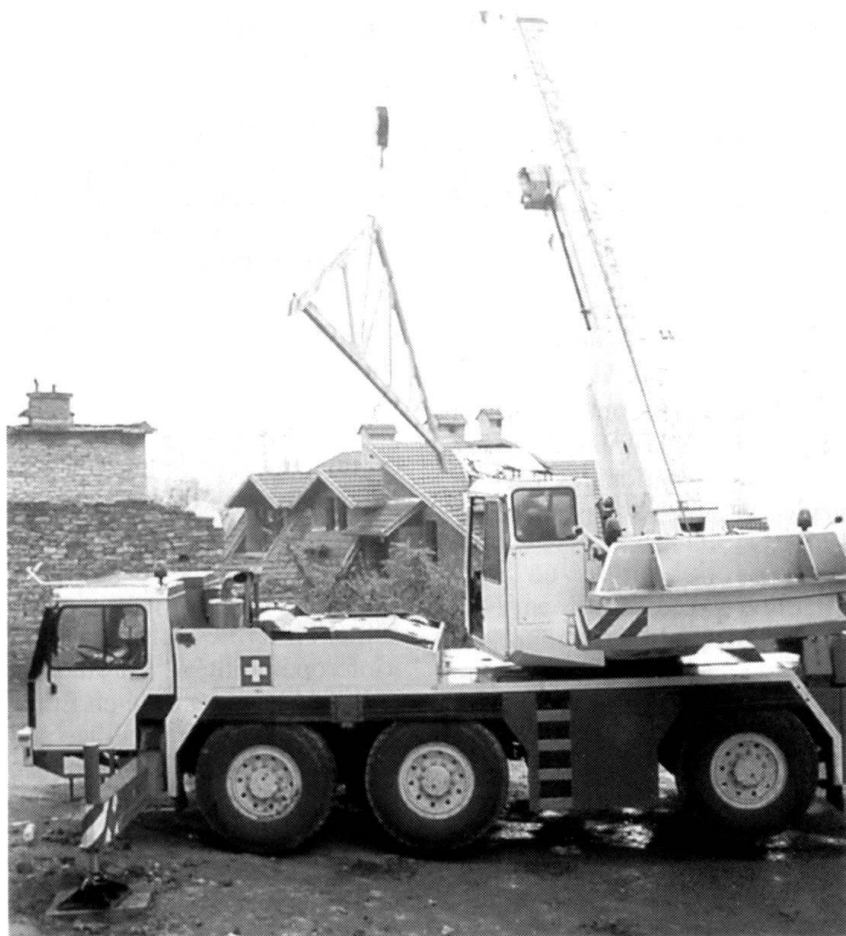
Des moyens lourds sont engagés par la SWISSCOY pour ses travaux de remise en état des infrastructures. (Photo: AFO).
