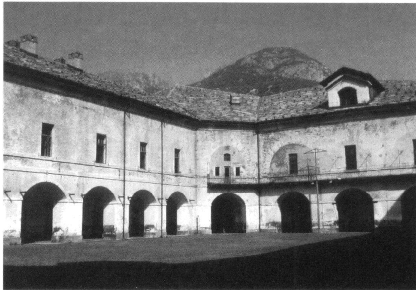
Le fort «Carlo Alberto». La cour principale.
